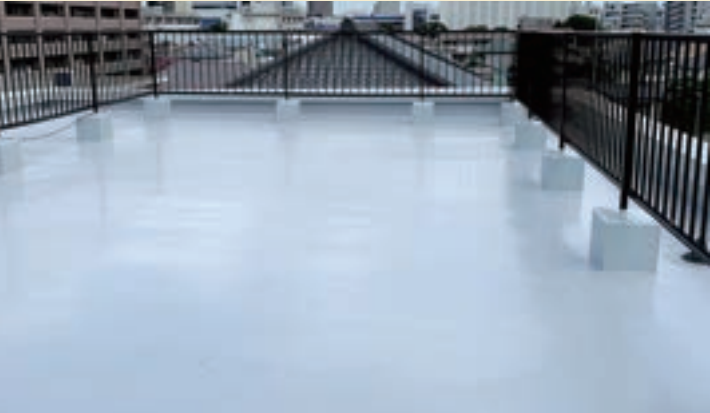
屋上防水工事
